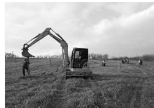
Při práci hodně pomohla technika – při hloubení děr i instalaci kůlů.
